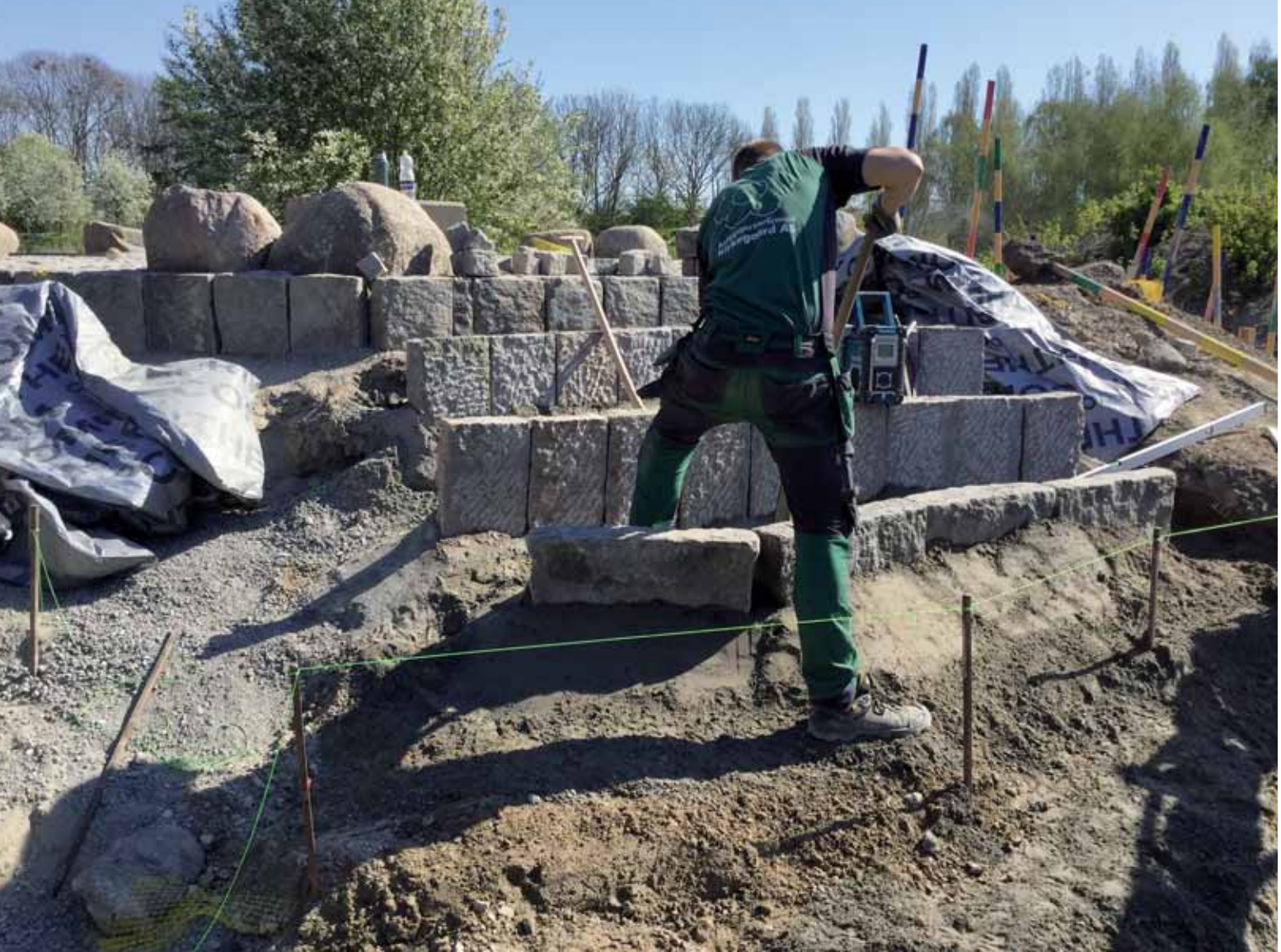
• En ansat fra Anlægsgartnerfirmaet Kirkegaard A/S er i færd med at sætte trappens stødtrin kantsten i beton på Mikadobakken. Trinfladerne er bagefter belagt med Kebony-træ mens skråningerne er tilplantet med bærbærende buske. Foto: Anlægsgartnerfirmaet Kirkegaard A/S.
