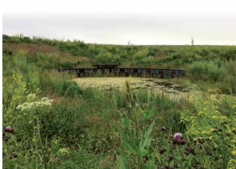
• Lystrup: Forsinkelsesbassin i den sydlige del af byen ved motorvejen. Her er der lavet et rekreativt opholdssted i forbindelse med indløbet til et stort rør der fører klimavand ned til Ellebæk og derfra ud i Egå Engsø. Foto: Signe Iversen, Aarhus Kommune.
