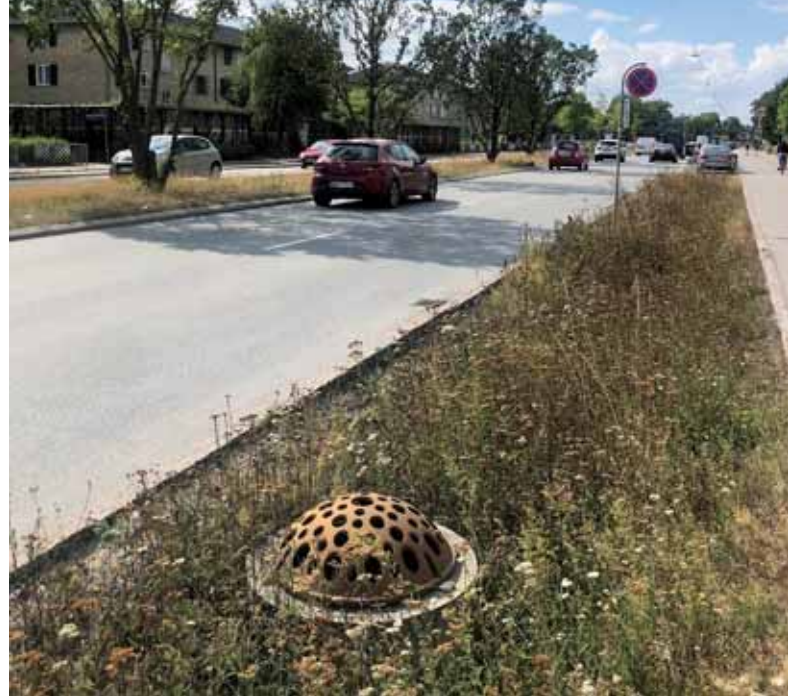
• Regnvand ved indfaldsvej. Foto fra håndbogen af Schönherr.
