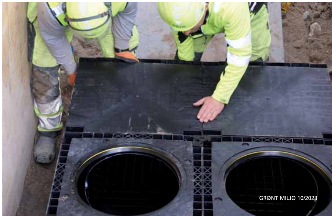
• Elementerne anbringes i jorden på Betty Nansens Allé. Der er ikke brug for membraner. Foto: UWR System.
