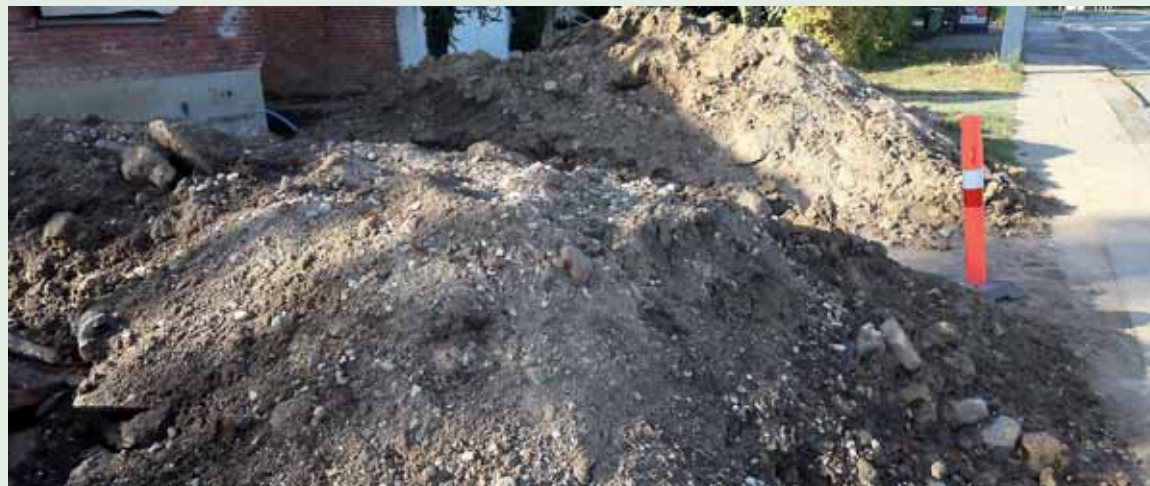
• Selv mindre projekter som denne bygnings- og haverenovering kan medføre ganske store jordmængder.
