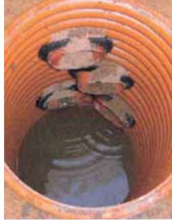
Der er ført flere påboringer ind i spulebrønden. Er den stærk nok? Foto: Kloaktuelt, december 2022.
