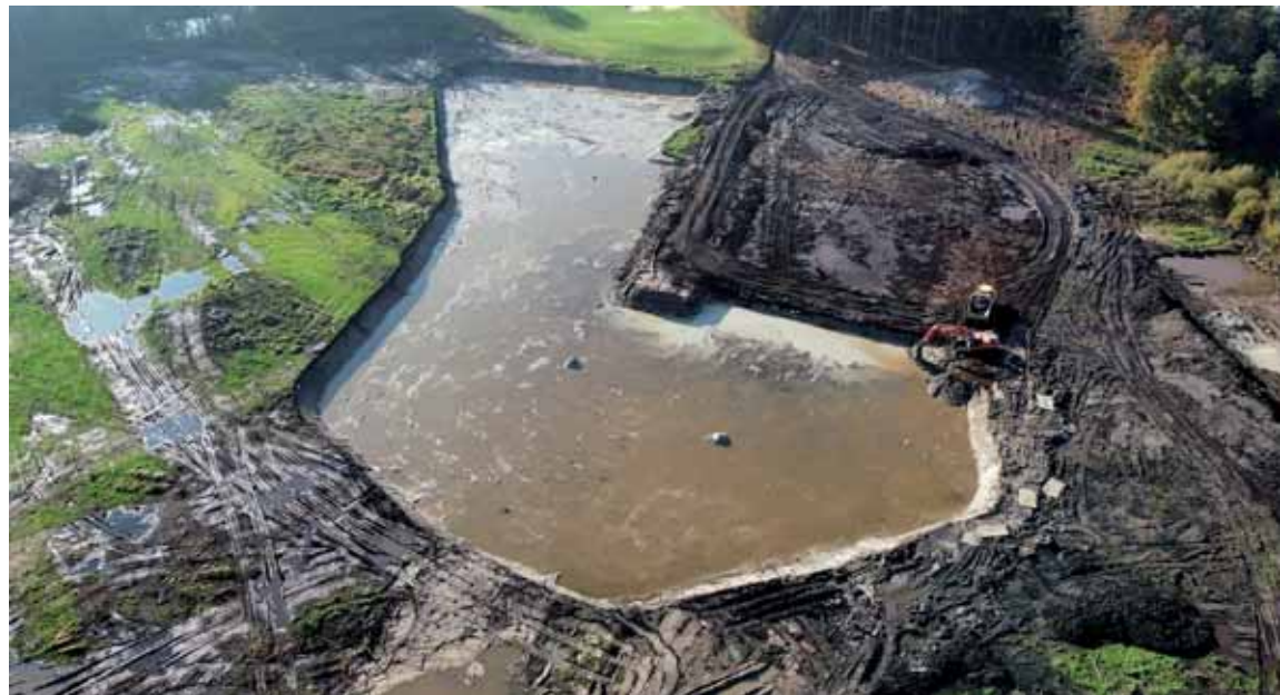
• Reservoirudgravning oktober 2021. Midt i det 5 hektar store reservoir er de midterste 1,5 hektar gravet 4 meter dybere. Den opgravede jord er anvendt til en jordvold og terrænregulering på et tilstødende areal hvor der snart bliver plantet erstatningsskov. Foto: The Scandinavian.
