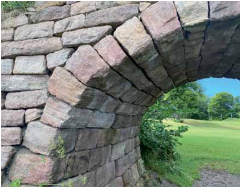
• Diget er rettet op efter den seneste istandsættelse, ingen sten skrider.
