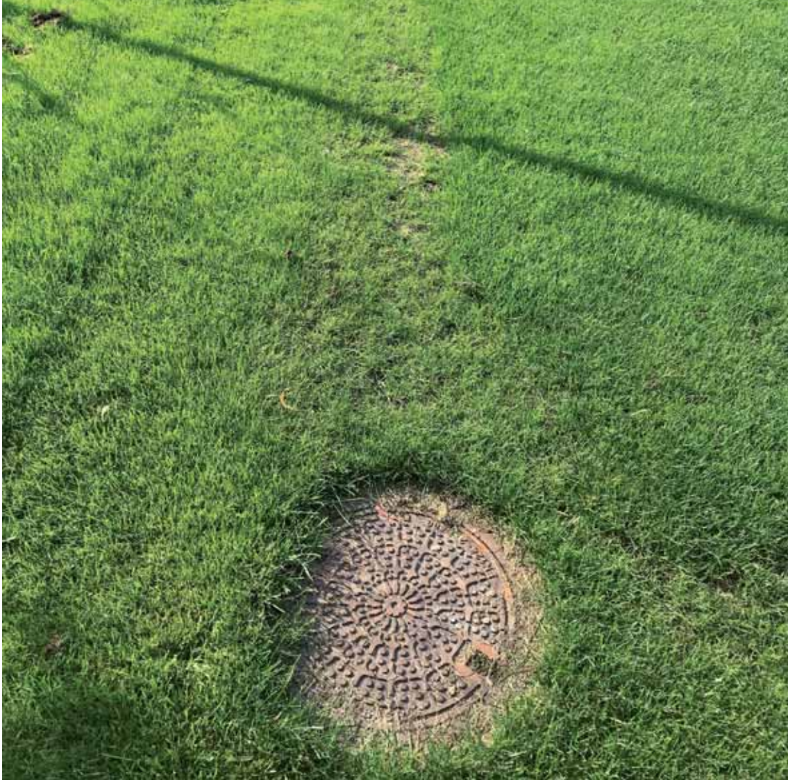
• Boldbaner er et af de steder hvor der stadig udføres dræning i grønne områder. Dræningen har ikke kun det basale mål at sænke grundvandsspejlet, men også at få overfladen hurtigere tør. Foto: Rørcentet.
