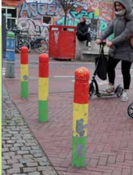
• Pullerter af stål i et byrum.
