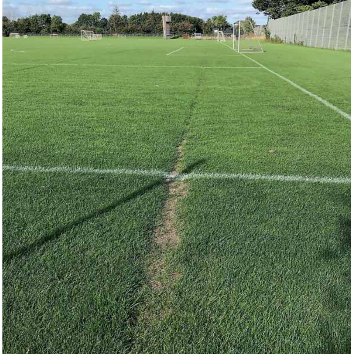
• Udtørret græs over drænrønder danner striber i græspelsen. For at modvirke det, skal sand- og grusfyldte drængrøfter ikke gå højere op end til råjordplanum. Foto: Rørcentet.
