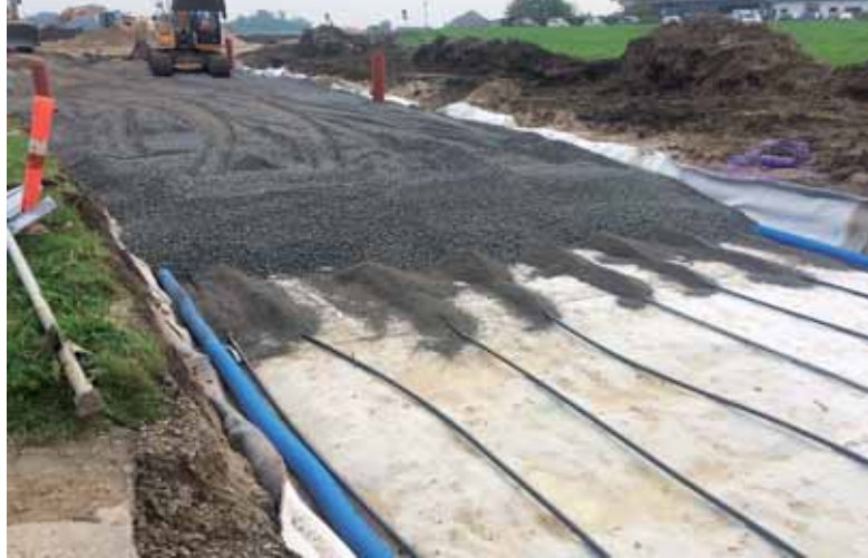
Testvejen under anlæg. De nederste slange er lagt på den hvide bentonitmåtte og pakkes ind i afrettingsgrus. Oven på er der lagt DrænStabil. Foto: Theis Raaschou Andersen.
