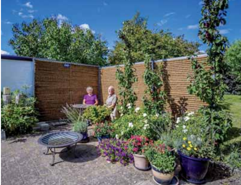
Den 2,0 meter høje støjskærm dæmpede her støjen med cirka 4,5 dB på siddepladserne inden for 1 meter fra støjhegnet. Hvis man sidder 2 meter fra hegnet, er støjdæmpningen mindre. Foto fra rapporten.
