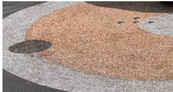
ASFALTCIRKLER. Består af 5/8 granitskærver udført med Vegecol transparent og vegetabilsk bindemiddel. Anlagt af DOB.
