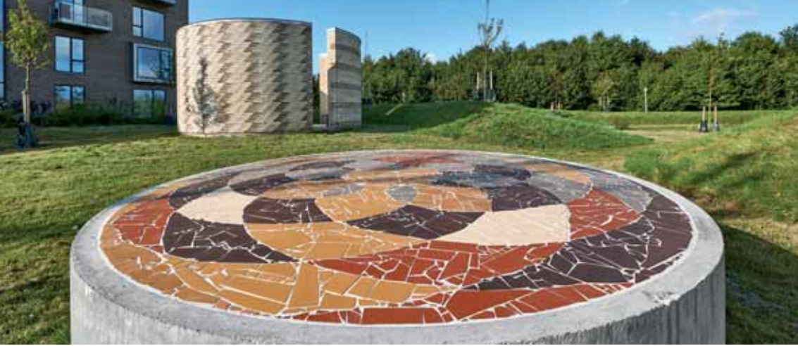
SCENERNE. Betonrør med betonkerne, uglaserede frostfrie TEC spaltklinker fra Mosaik Hjørnet i farverne: grå, brun, rød, gul, efterårsgul og beige. LIP multifliseklæb + LIP multifuge i grå, hvid og manhattan. Rengøres en gang årligt med børste og ude-grundrens.
