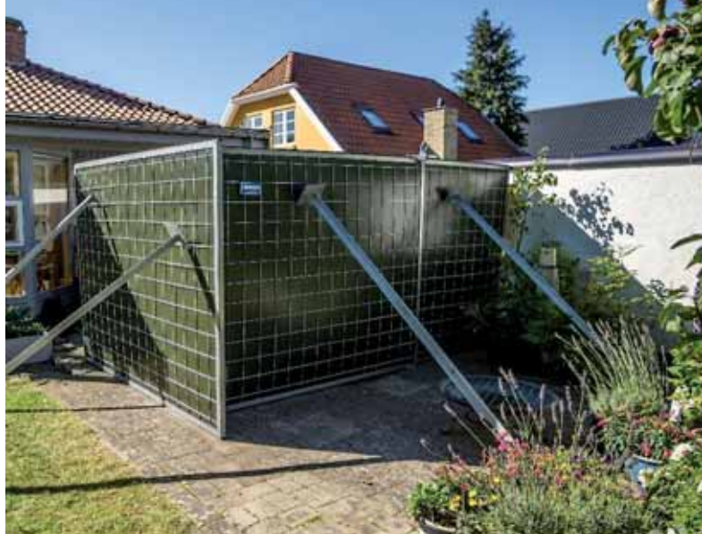
Støjskærm har også et visuelt aspekt. Her ses skærmen mod dens støjreflekterende yderside. Den er 2 meter høj, men ville dominere i 2,5 meters højde. Støttekonstruktionen er midlertidig. Foto fra rapporten.
