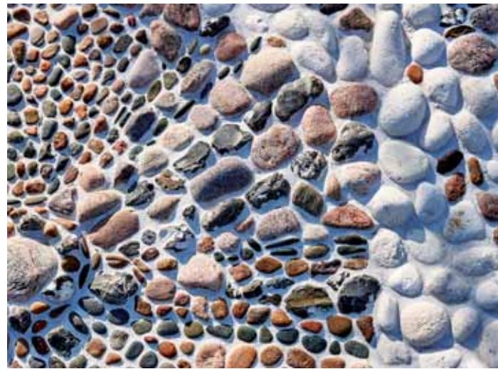
SANSEHAVEN. Betonrør med betonkerne, LIP multifliseklæb + LIP multifuge i grå, hvid og manhattan. Sten: sønødder og hvide singles fra Maxibag. Rengøres en gang årligt med stivkost og udegrundrens.
