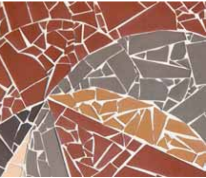
SCENERNE. Betonrør med betonkerne, uglaserede frostfrie TEC spaltklinker fra Mosaik Hjørnet i farverne: grå, brun, rød, gul, efterårsgul og beige. LIP multifliseklæb + LIP multifuge i grå, hvid og manhattan. Rengøres en gang årligt med børste og ude-grundrens.
