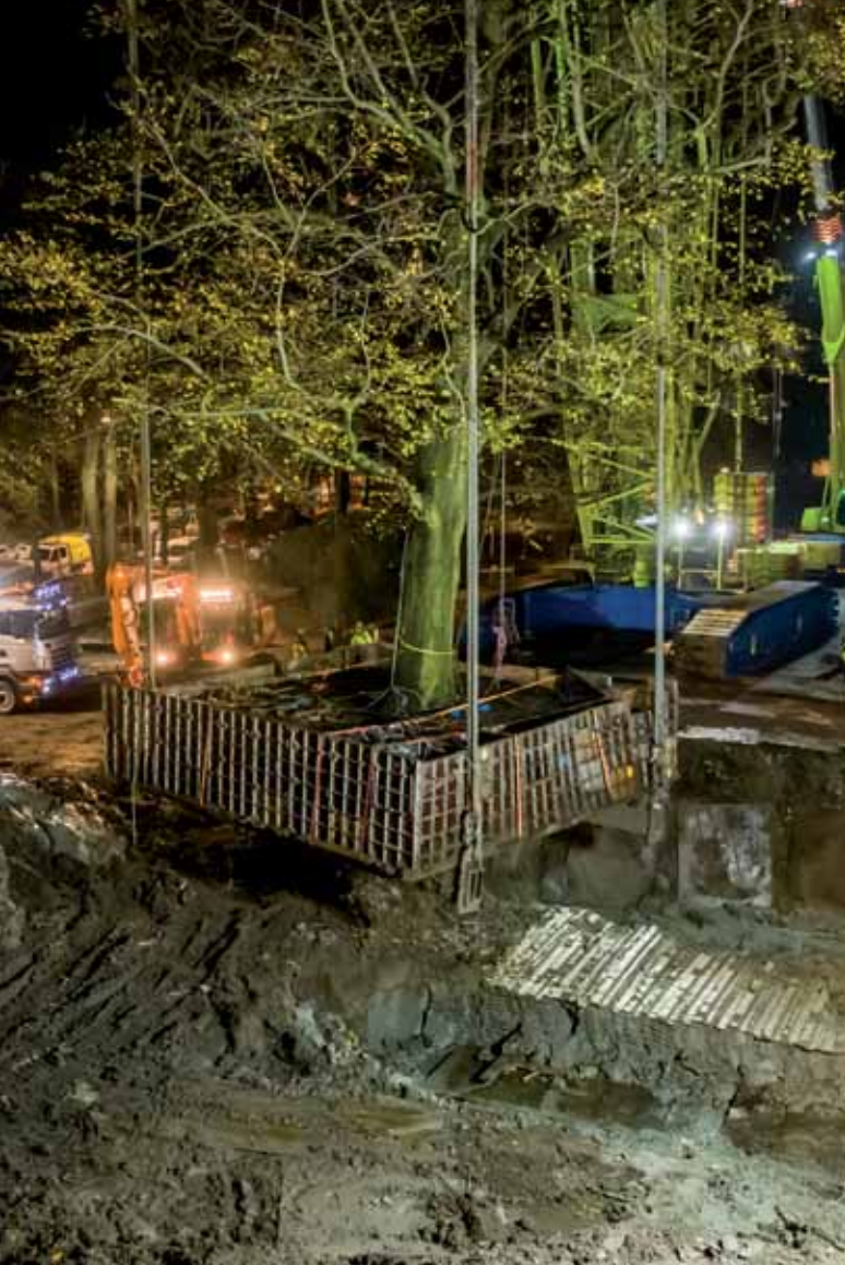
I et metroprojekt i Göteborg er 1423 træer i spil. 800 bevares, 100 flyttes inden for anlægsområdet. 200 flyttes midlertidigt til en planteskole. Og 323 opgives og erstattes af nye. Det største træ, en bøg, vejede med klump 187 ton og blev flyttet med kran 30.10.2018. Det var forinden rodkåret og begrænset 15-20% i kronvolumen. Foto: Örjan Stål.
