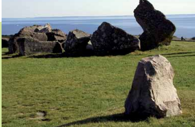
Betonrester af de sprængte krudtmagasiner i Dybbøl. Foto: Historiecenter Dybbøl Banke.
