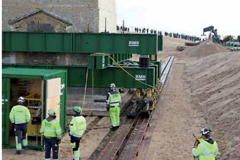
Fyret er løftet 6 cm og flyttes frem i afgravningen Foto:Kim Krasuld.
