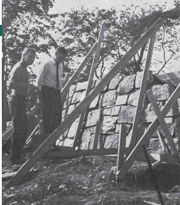
Øivind Svendby A/S bygger støttemur ud mod søen. Anlægsgartneren, oktober 1969.
