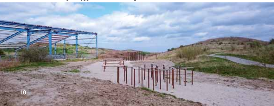
Stålskeletter fra tidligere byggerier minder om Stige Øs fortid. Foto: Martin Prassé.
