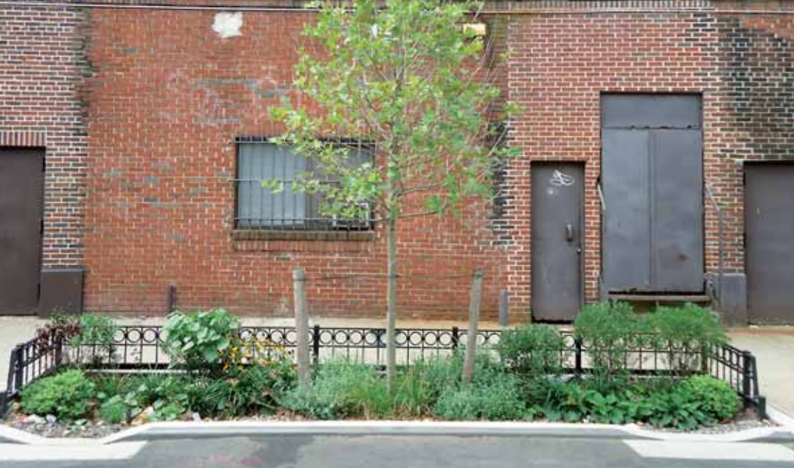
To huller i kantstenen agerer ind- og udløb til de 3-6 meter lange regnbede. Foto fra Nyc.gov.
