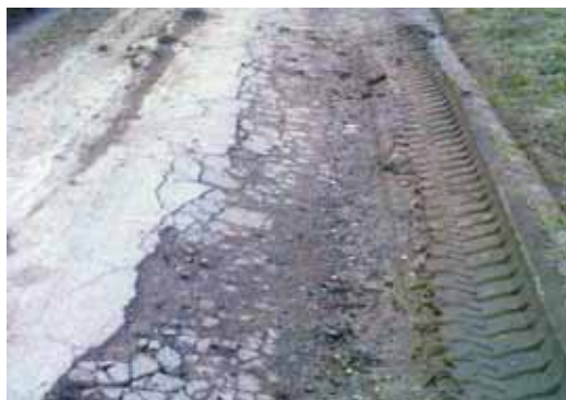
En totalt nedslidt vej. Til højre renoveringens 1. trin: sammenfræsning af hele vejkassen. Fotos: J. Hesselberg.
