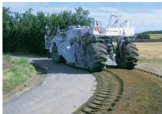
En totalt nedslidt vej. Til højre renoveringens 1. trin: sammenfræsning af hele vejkassen. Fotos: J. Hesselberg.
