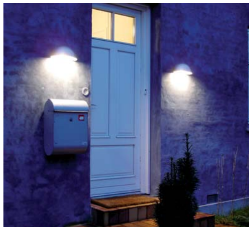
Armaturerne til venstre er fuldt afskærmede og sender kun lys nedad. Foto: P.T. Aldrich.
