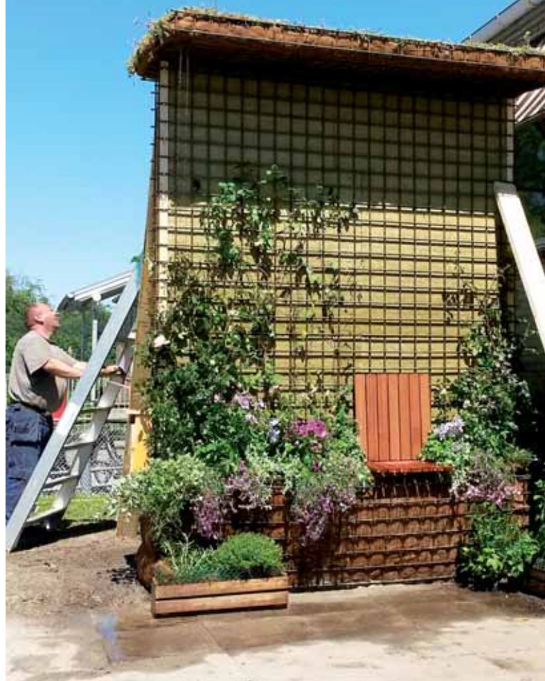
Model af en grøn gabion. Den er bygget op af tre elementer og kan tage et parcelhus' tagvand, mens bundelementets 80 cm vækstlag giver mulighed for en varieret beplantning.
