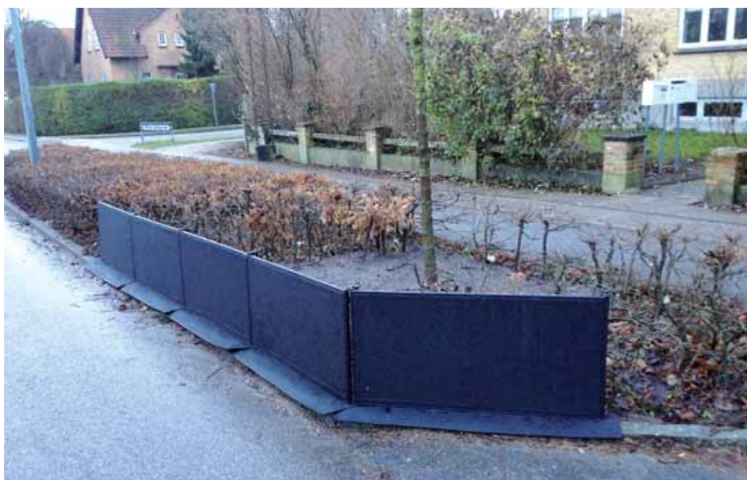
Saltværn på Ringgade. Jernrørene stikkes i jorden, ikke i kantstenens understøbning. Et skørt leder saltsprøjtet ud over kantstenen. Fotos: Sønderborg Kommune.
